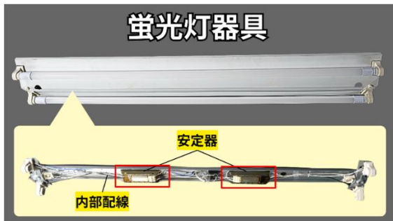
「蛍光灯器具」内部の様子
