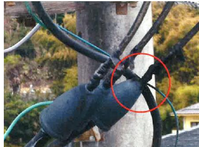
PAS制御線と高圧引込ケーブルの接触箇所（拡大図）
