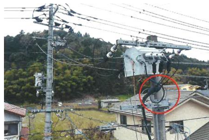
PAS制御線と高圧引込ケーブルの接触箇所（拡大図）
