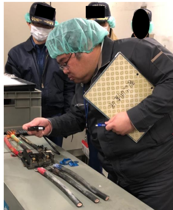
例2 焼損した端子台の調査
