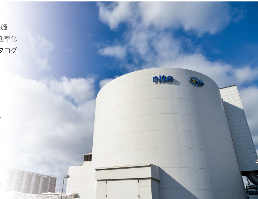
多目的大型実験棟(大阪事業所)
