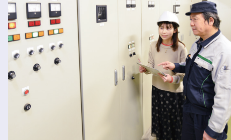
各種設備の更新や部屋の リニューアル工事等にも 携わる
