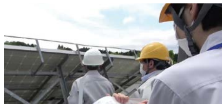
太陽光パネルの検査
