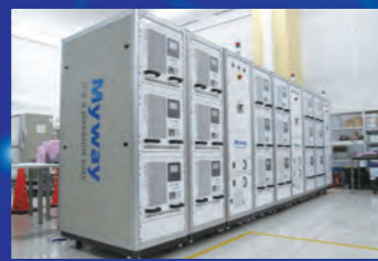
充放電試験 温度可変環境下での充放電試験が実施可能です。
